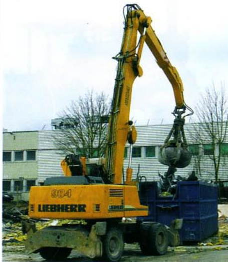
Le tri des matériaux est assuré par une pelle Liebherr 904 équipée d'un grappin hydraulique
